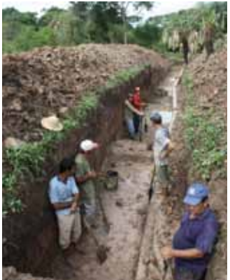
Bau des Greenfilters, Paraguay
