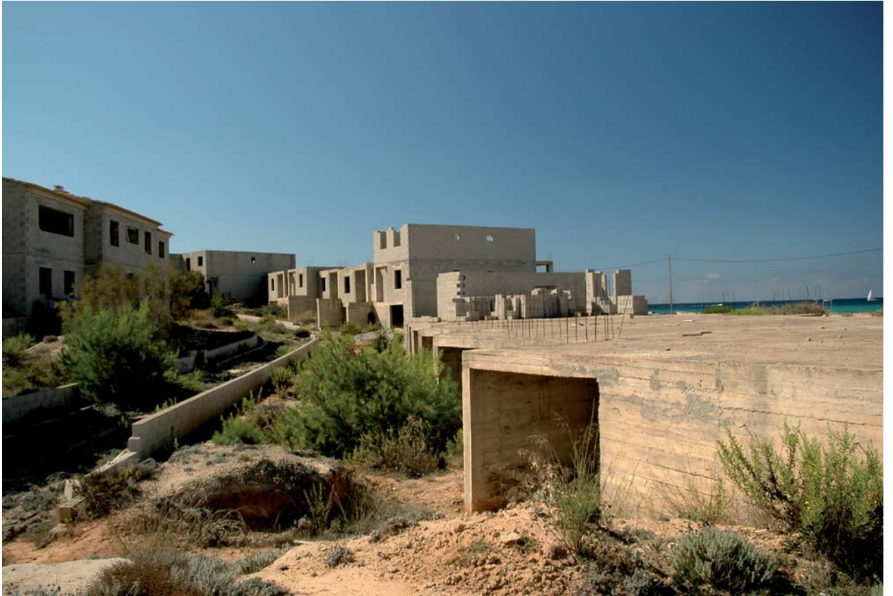
Die hässlichen Bauten in Ses Covetes am Strand von Es Trenc wurden illegal errichtet. Dank des GOB müssen sie bald endgültig abgerissen werden.
