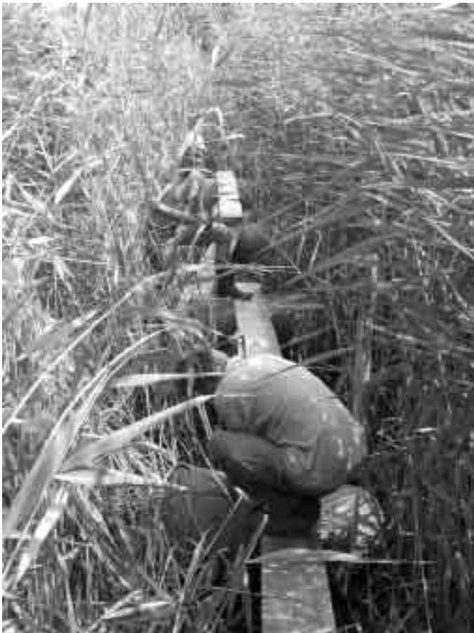
Κατασκευή πλωτής γέφυρας για τις επιστημονικές μετρήσεις νερών
