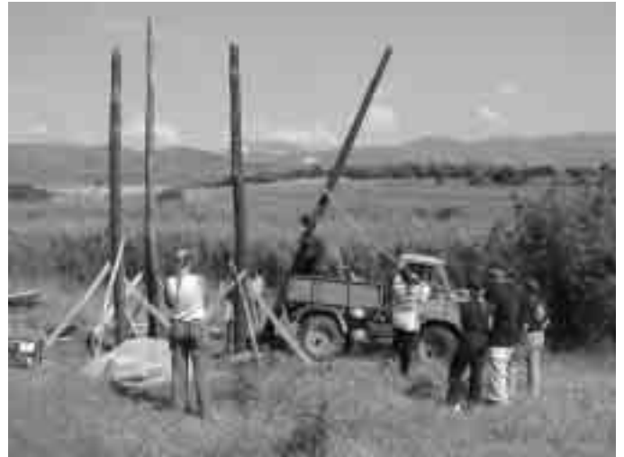
Κατασκευή παρατηρητηρίου από τους εθελοντές της κατασκήνωσης, καλοκαίρι 2004
